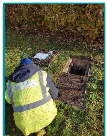
Maintenance du piézomètre du CD77 à Gretz-A. le 8 novembre
