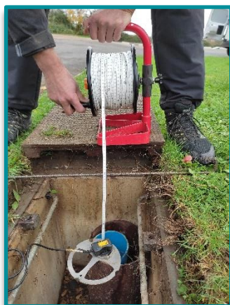
Contrôle du niveau mesuré par la station au piézomètre du CD77 d'Evry-Grégy le 17 novembre
