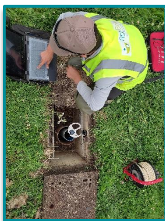
Maintenance du piézomètre du CD77 de Roissy-en-Brie le 13 août
