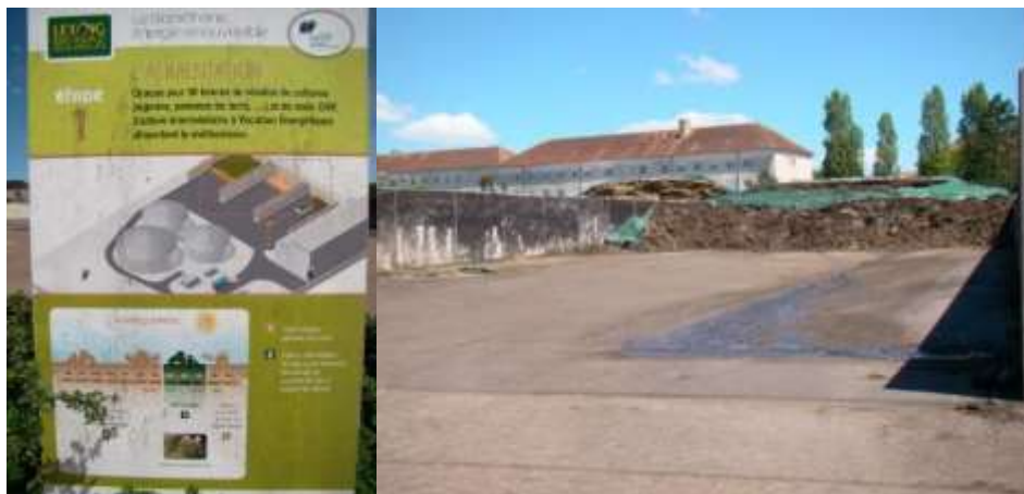
Silo de stockage de la matière première qui va rentrer dans le méthaniseur
